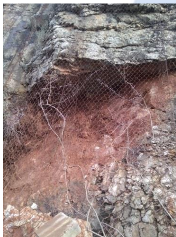
Fotografije: Odron stijene u zasjeku na trasi autoceste A6 Rijeka – Zagreb, dionice Oštrovica – Kikovica u km 69+750.
